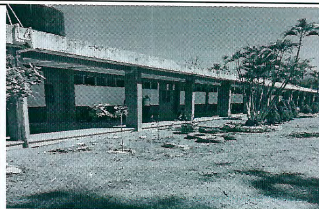
Foto 2: Pintura en muros interior y exterior.
