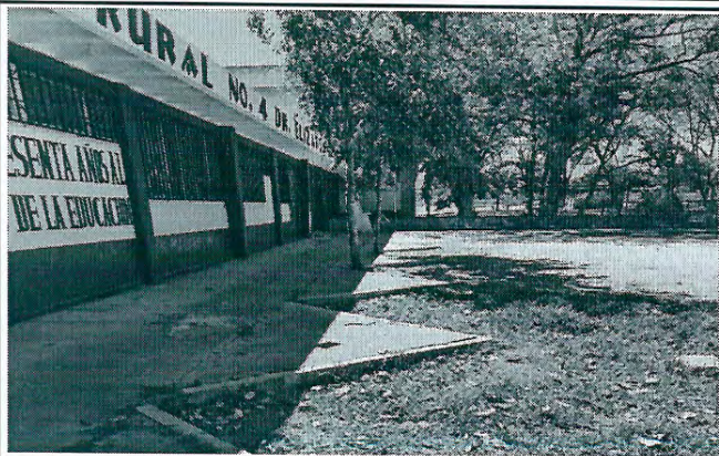
Foto 1: Area donde se hara los trabajos reparacion de red de drenajes y red de agua potable.
