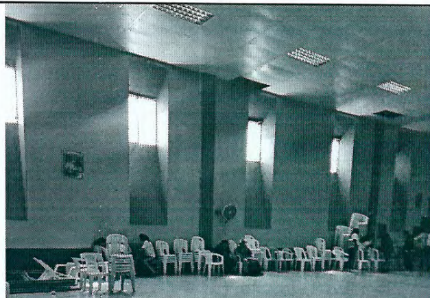
Foto 4: Pintura en muros interior y exterior.
