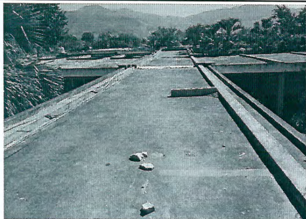
Foto 3: Impearmabilizacion de losa
